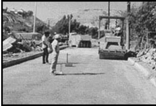
Figura 8. Procedimiento constructivo de una base tratada con cemento.
