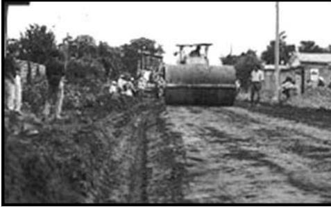
Figura 6. Proceso constructivo del suelo-cemento.
