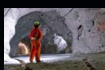
3er. Lugar Infraestructura Sostenimiento de la Mina Tizapa Zacazonapan, Estado de México • Representante: Ing. Gonzalo Galicia Jiménez • Construcción: Minera Tizapa, S.A. de C.V., Ing. Francisco Gómez • Diseño Estructural: Minera Tizapa, S.A. de C.V.
