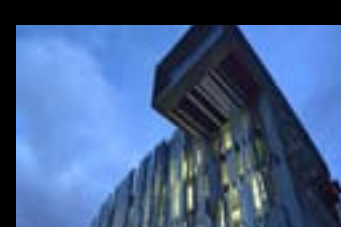
1er. Lugar Innovación en Técnicas y Procesos Constructivos Edificio BAF. Atlixpán de Zaragoza, Estado de México • Representante: Arq. Rafael Barona Coghlan • Construcción: Ing. Francisco Barona Mariscal, Ing. Francisco Barona Coghlan, Arq. Rafael Barona Coghlan, Arq. Rodrigo Romo de Vivar, Ing. Arq. Rodolfo Jiménez Rojano, Arquitecturame S.A. de C.V. • Proyecto Arquitectónico: Arq. Rafael Barona Coghlan, Arq. Valeria Arizmendi Castillo, Arq. Ariadna Vivencio, Arq. Sergio Alvarez, Arq. Joel Beltrán, Arquitecturame S.A. de C.V. • Diseño Estructural: Ing. Arq. Rodolfo Jiménez Rojano, Ing. Daniel Padilla, Arquitecturame S.A. de C.V.
